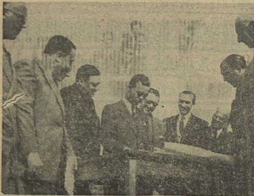
O Ministro das Obras Públicas, acompanhado pelos dirigentes do Sporting, observando os planos do novo Estádio, durante o visita hoje feita às obras
