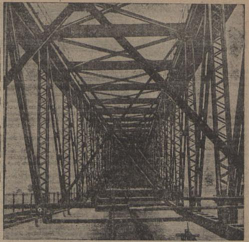
Um emaranhado de vigas de ferro — o tramo provisório para assentamento do primeiro troço da ponte metálica
