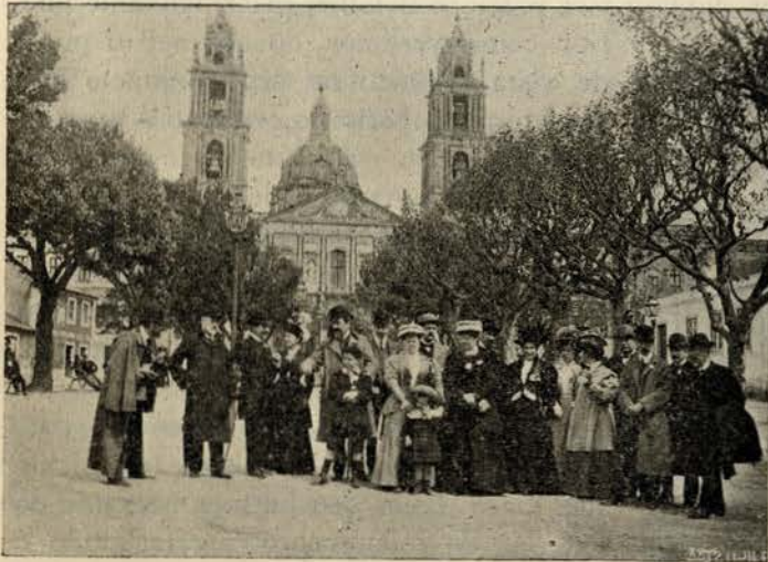
A situação do edificio, orientado oeste-leste
