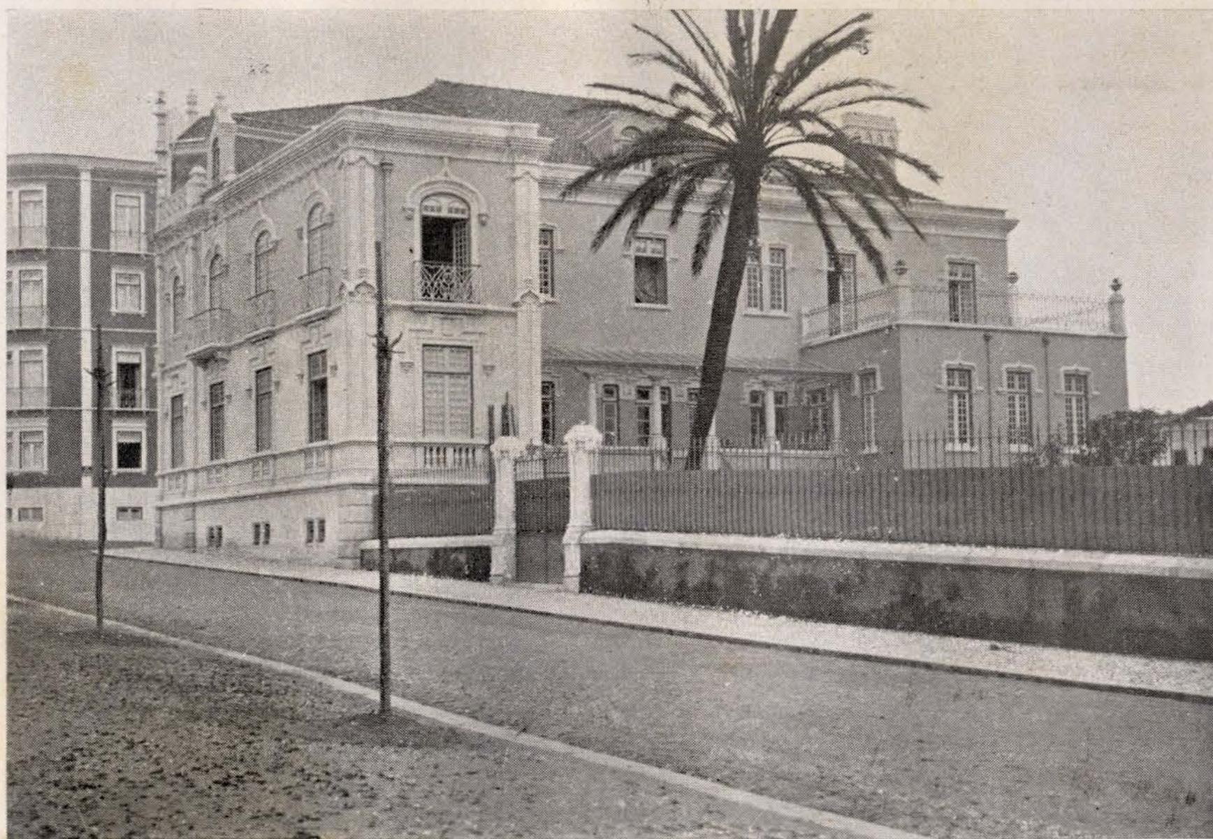
Fachada sobre o jardim
