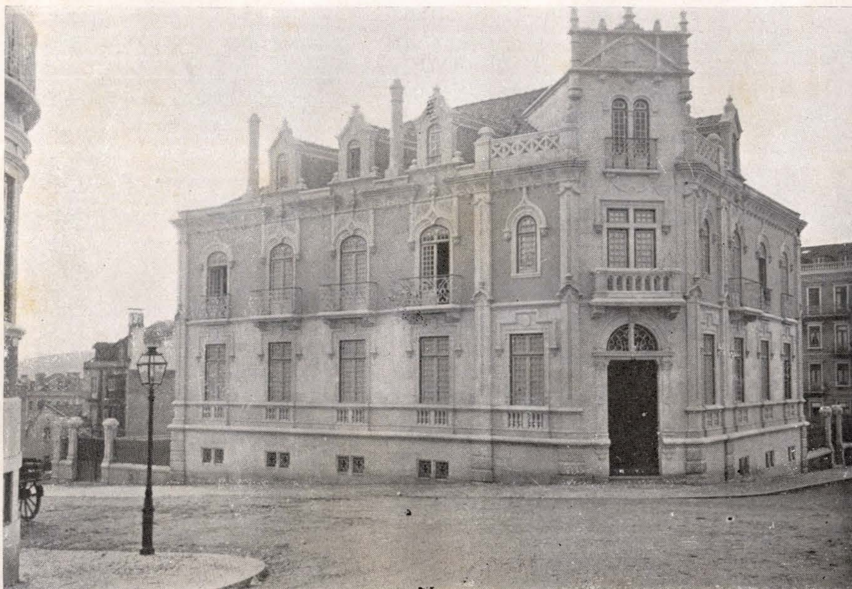
Casa do sr. Empis — Lisboa — Fachada sobre a via publica
