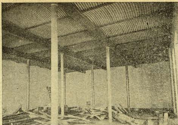
Vigamentos com abobadas metallicas da fabrica em Xabregas
