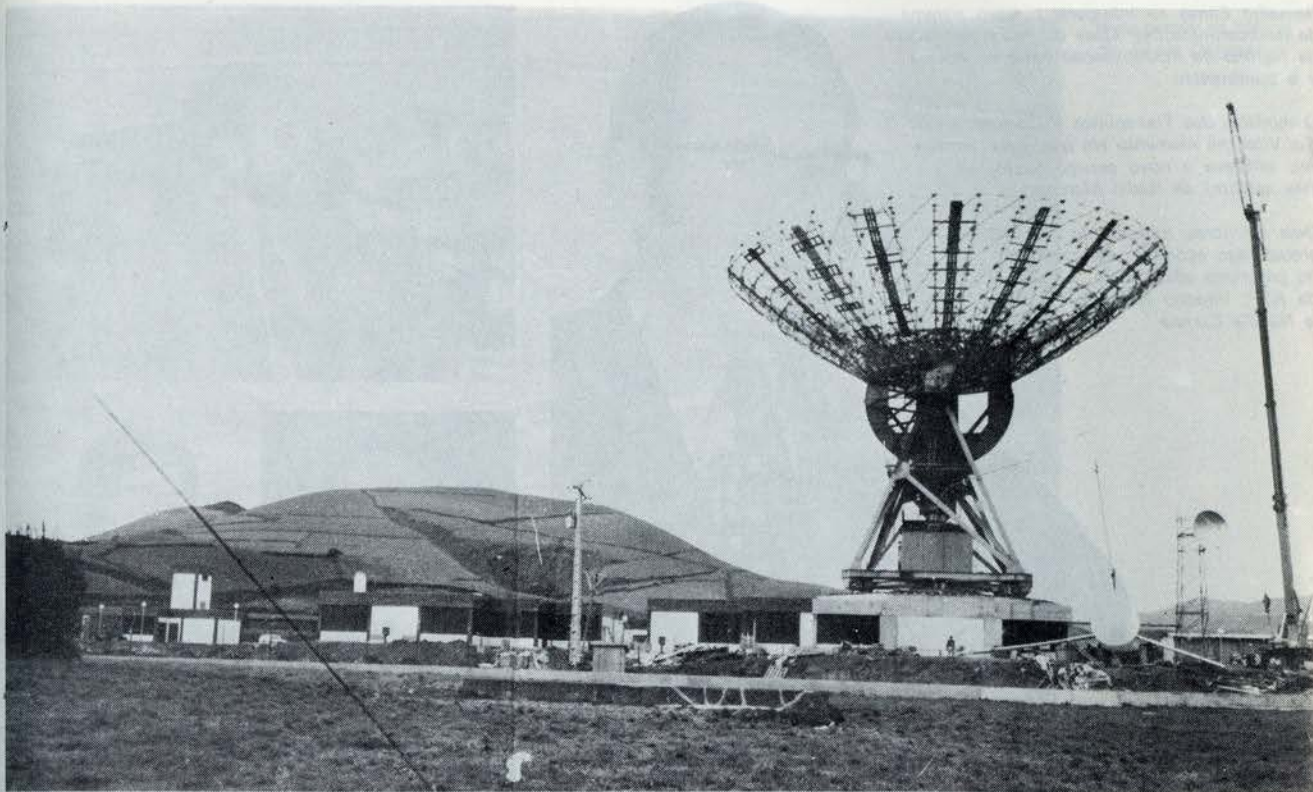
A nova estação terrestre de telecomunicações (via satélite) de Ponta Delgada
