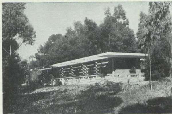
POR ENTRE O ARVOREDO FRONDOSO, APARECE UM BLOCO SANITÁRIO
