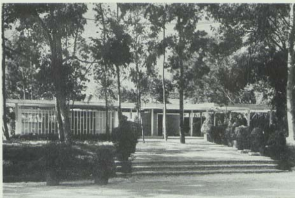
ASPECTO GERAL DO BLOCO DESTINADO A «RECEPÇÃO, CONVÍVIO E ABASTECIMENTO».
