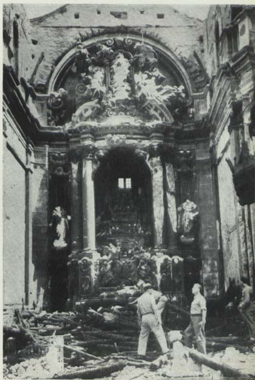
NO RESCALDO DO INCENDIO DA IGREJA DE SÃO DOMINGOS
