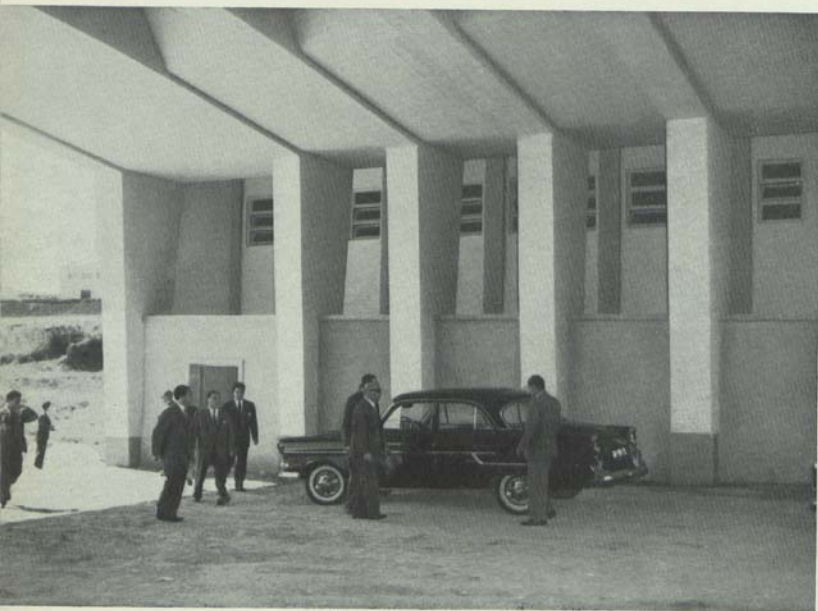
NO VIADUTO GENERAL ROÇADAS
