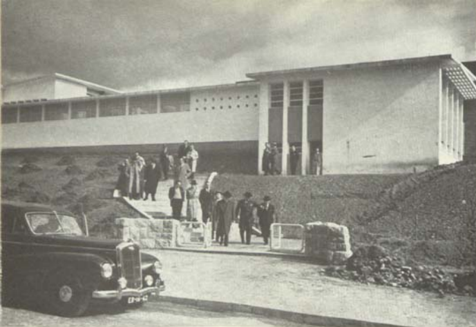
PRIMEIRA VISITA DA NOVA VEREAÇÃO AOS BLOCOS ESCOLARES EM CONSTRUÇÃO
