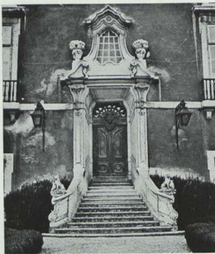
Porta que dava acesso ao andar das aulas pelo jardim de buxo
