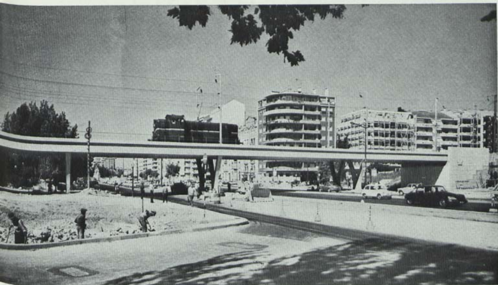
ENTRADA EM FUNCIONAMENTO DO NOVO VIADUTO FERROVIÁRIO SOBRE AS AVENIDAS DA REPÚBLICA E 5 DE OUTUBRO
