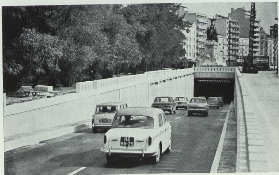
ENTRADA EM FUNCIONAMENTO DOS TUNEIS RODOVIÁRIOS DE ENTRECAMPOS, LIGANDO NAS DUAS DIRECÇÕES A AVENIDA DA REPÚBLICA E O CAMPO GRANDE
