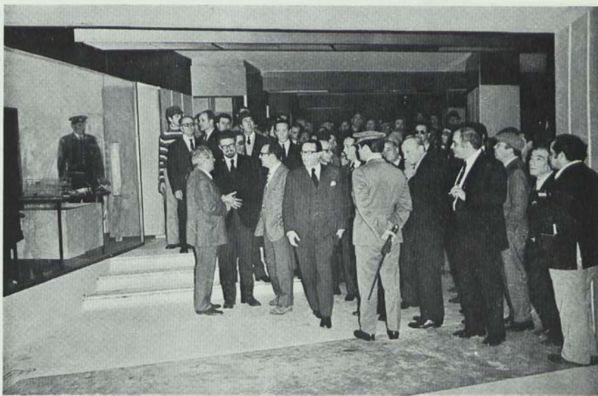
O ENG.º SANTOS E CASTRO INAUGURA A PASSAGEM SUBTERRÂNEA PARA PEÕES EM ALCANTARA
