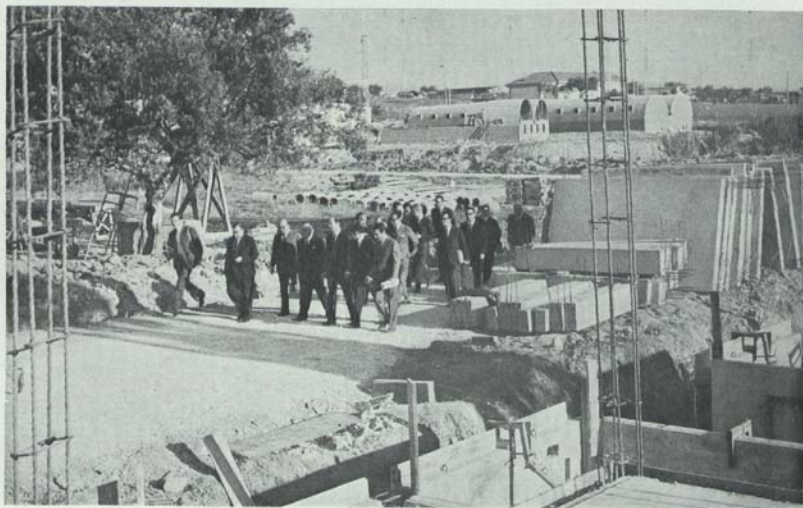
VISITA DO PRESIDENTE DA C. M. L. E VERAÇÃO AS OBRAS DO BAIRRO DA QUINTA DO MORGADO
