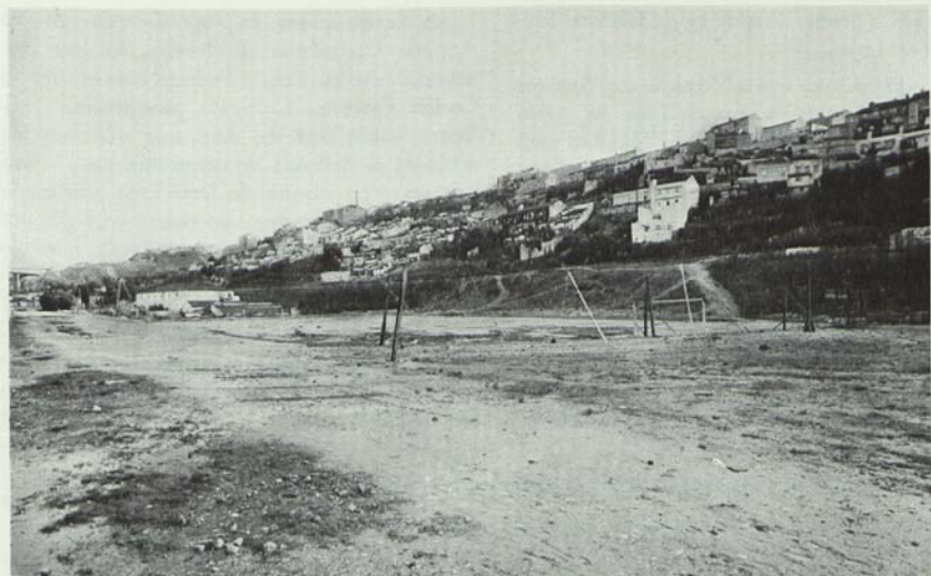
Imagem do Casal Ventoso e da Avenida de Ceuta, depois de demolidas as barracas ali existentes anteriormente
