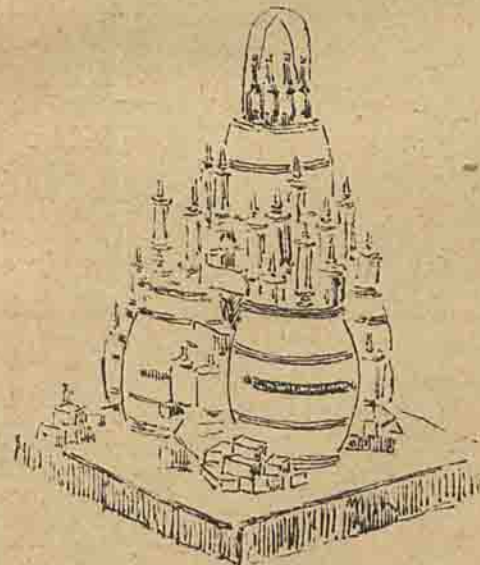
Instalação da fabrica Progresso Nacional , de refinação e chrystalisação d'assucar, de José Rodrigues Mendes, successores, na calçada de Santos, 25 a 35.
