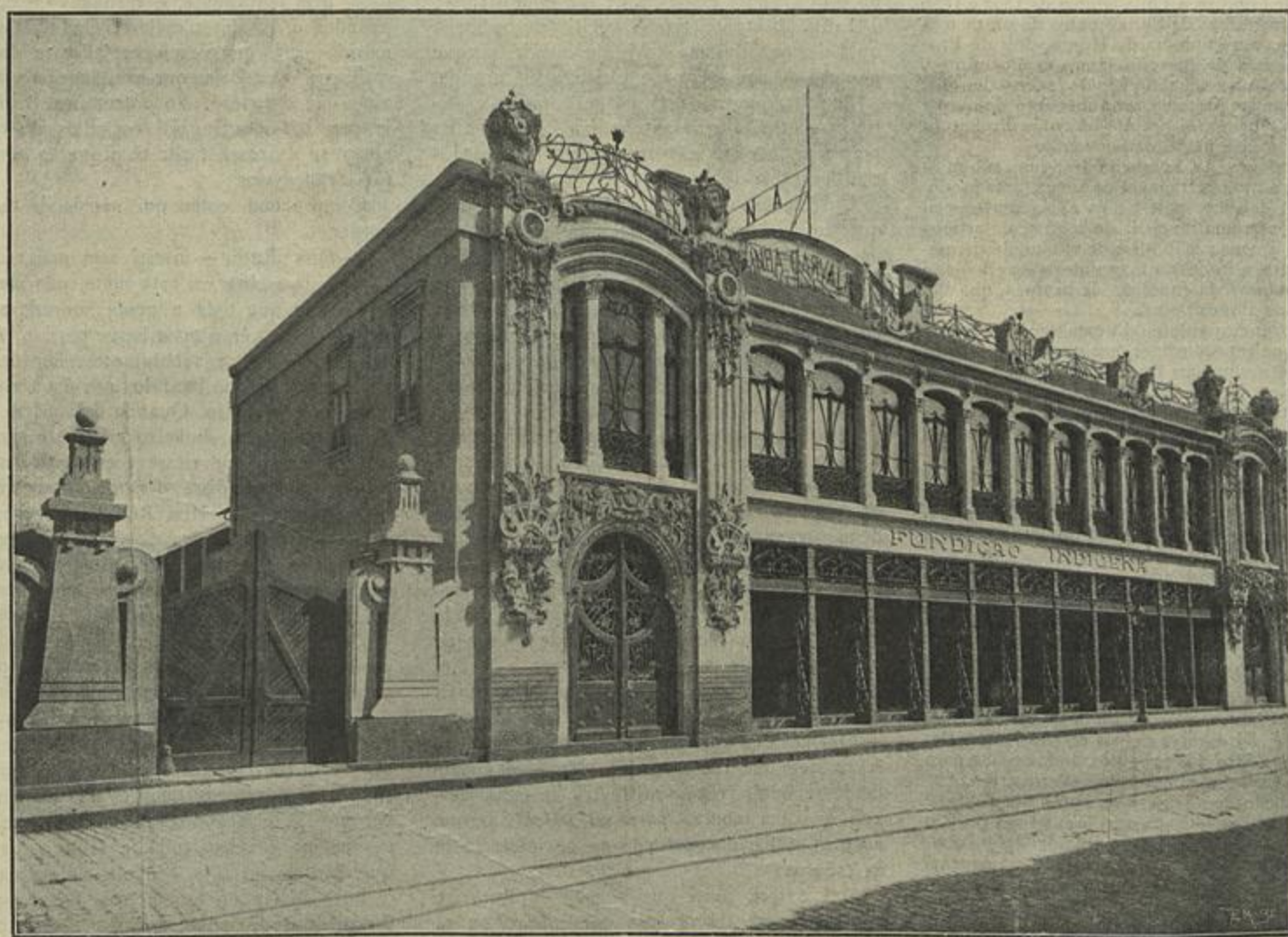
VISTA EXTERIOR DO NOVO EDIFÍCIO DA FUNDIÇÃO INDIGENA, NA RUA CAMERINO DO RIO DE JANEIRO, PROPRIEDADE DOS SRS. FARINHA, CARVALHO & C. a
