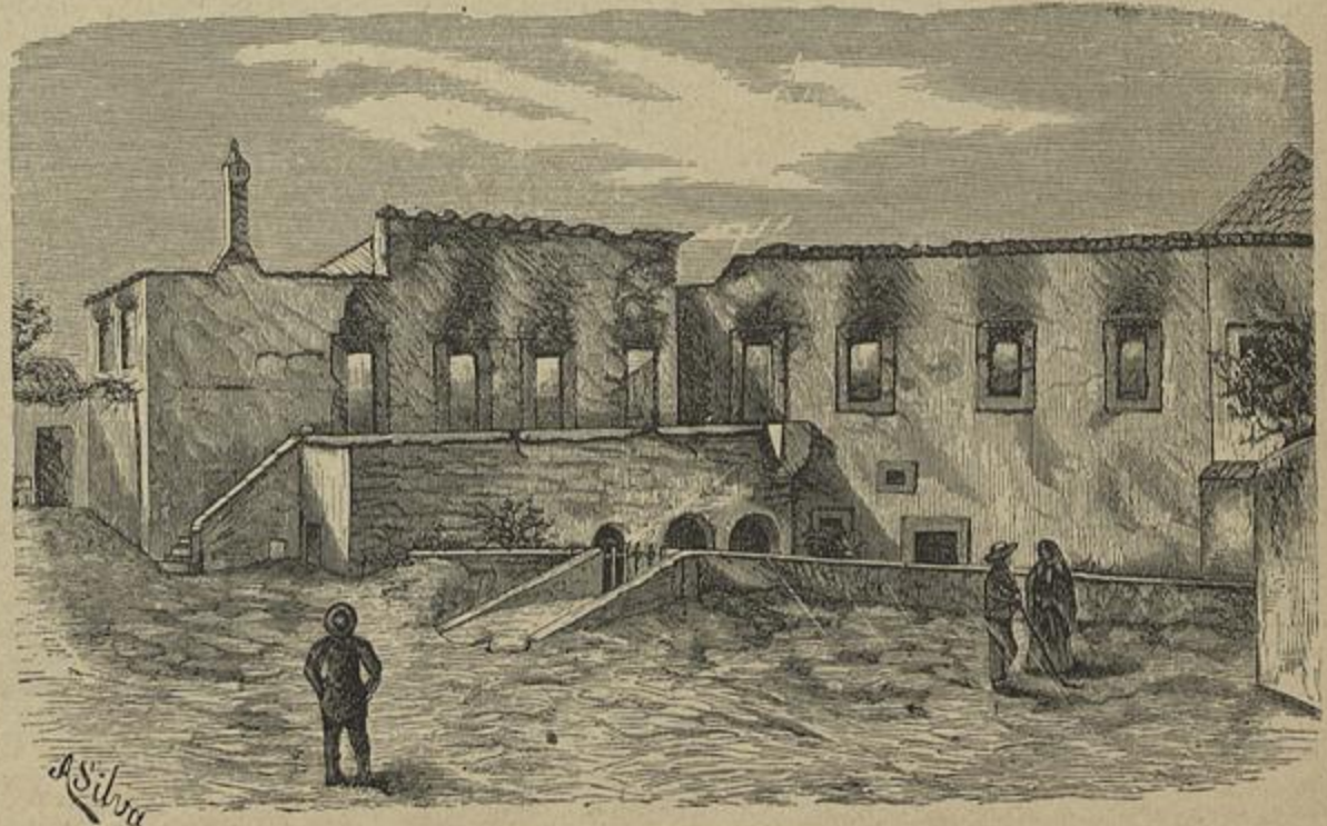
RUINAS DA CASA DEPOIS DO INCENDIO, VISTA DO LADO DO QUINTAL
