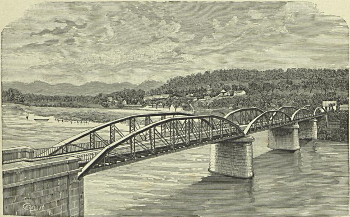
PONTE DA PORTELLA
