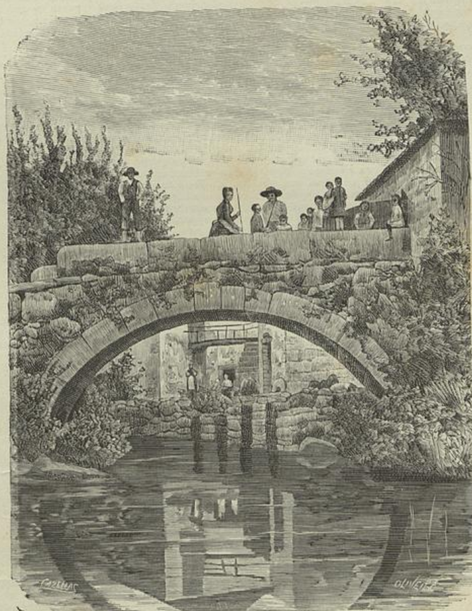
AVINTES — PONTE DO CADEADO
