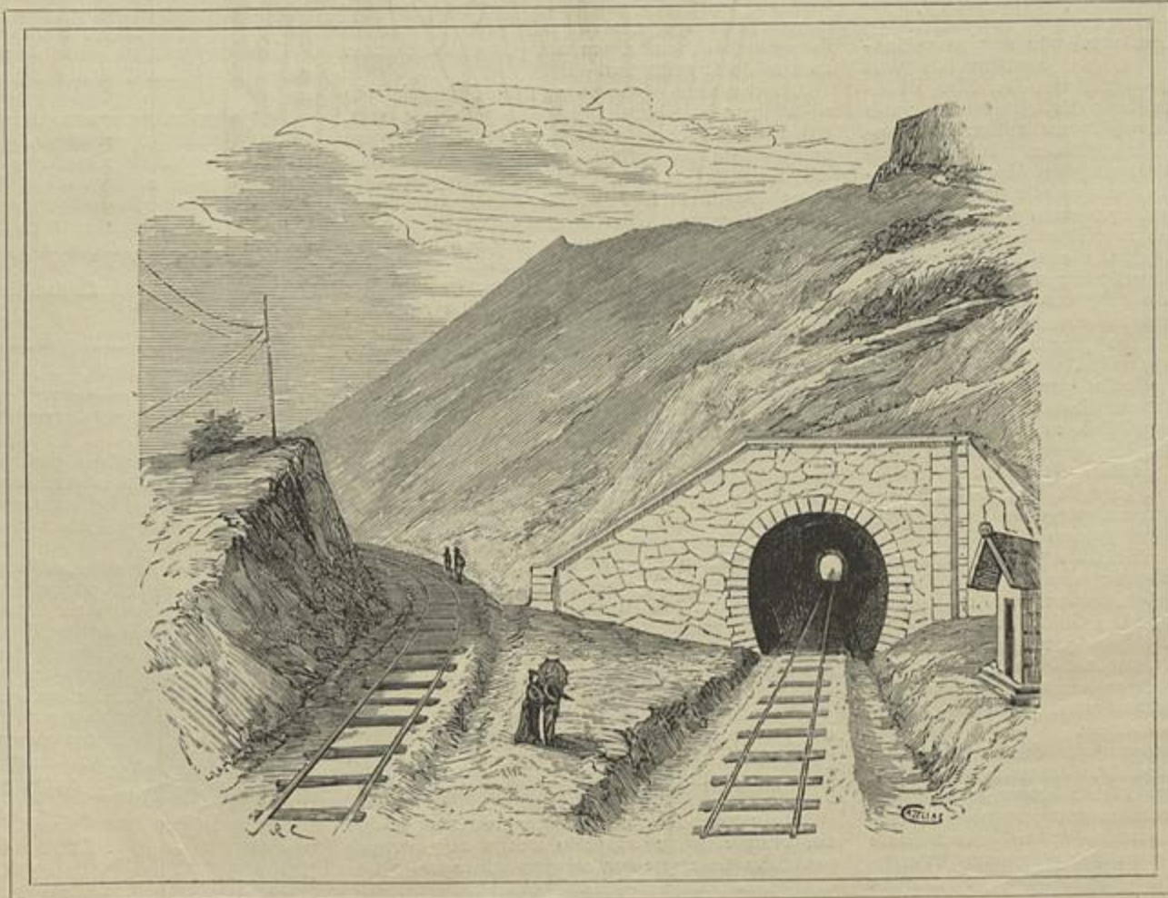
CAMINHO DE FERRO DE LISBOA A CINTRA—TUNNEL DOS TERREMOTOS (Desenho do natural por J. R. Christino)
