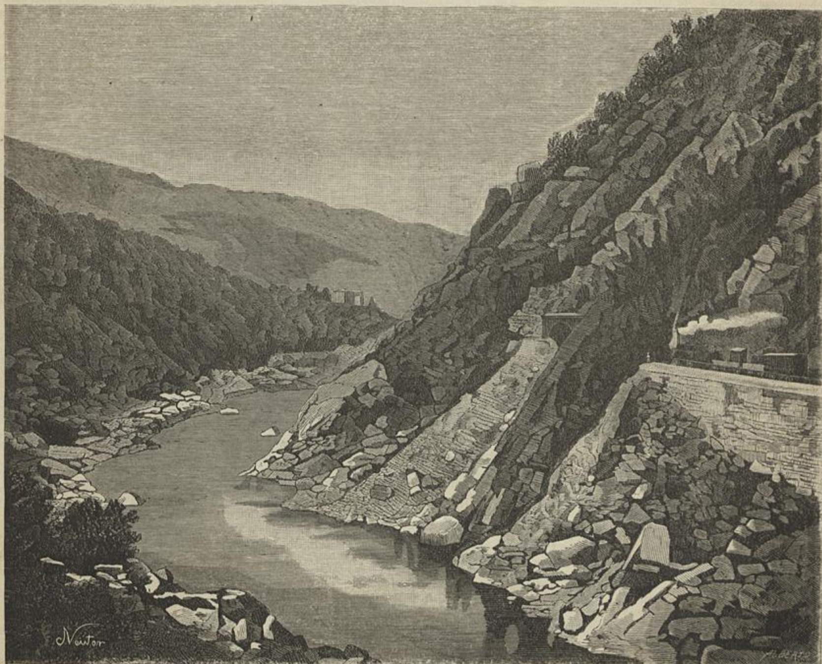
CAMINHOS DE FERRO PORTUGUEZES — CAMINHO DE FERRO DO DOURO, TUNNEL DO LOUREIRO (Segundo uma photographia de Biel)
