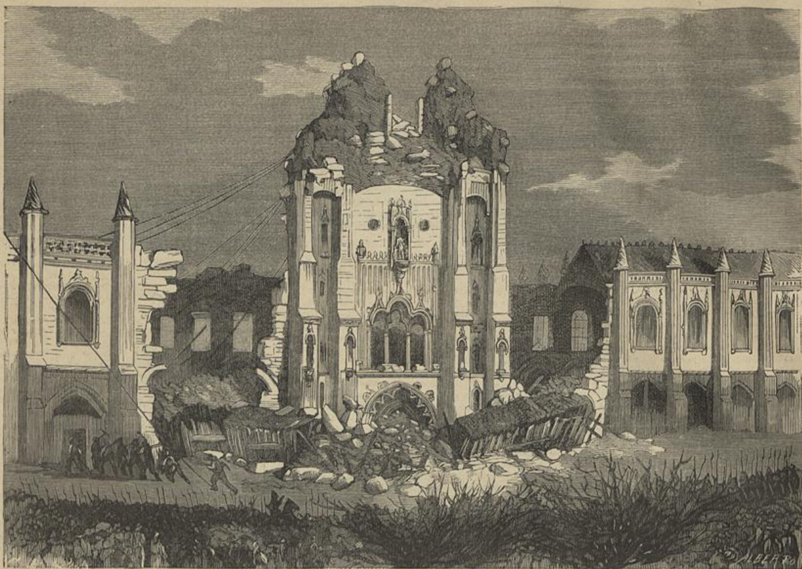
DESMORONAMENTO DO CORPO CENTRAL DO NOVO EDIFÍCIO DA CASA PIA, EM BELEM, OCCORRIDO NO DIA 18 DE DEZEMBRO DE 1878
