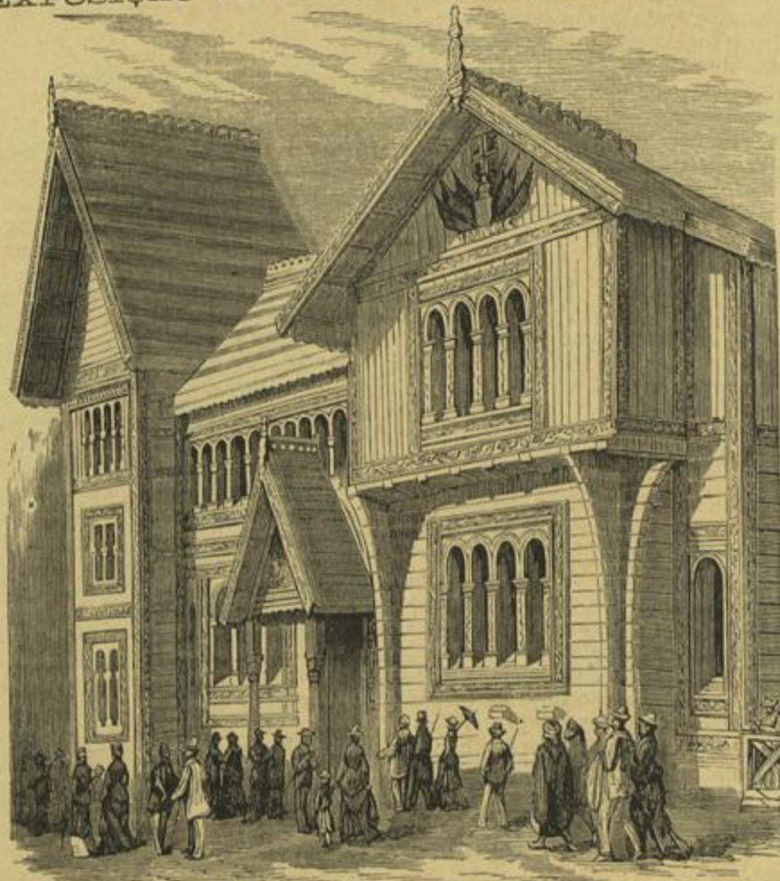
FACHADA DA EXPOSIÇÃO DA SUECIA E NORUEGA NA RUA DAS NAÇÕES (Segundo uma photographia)
