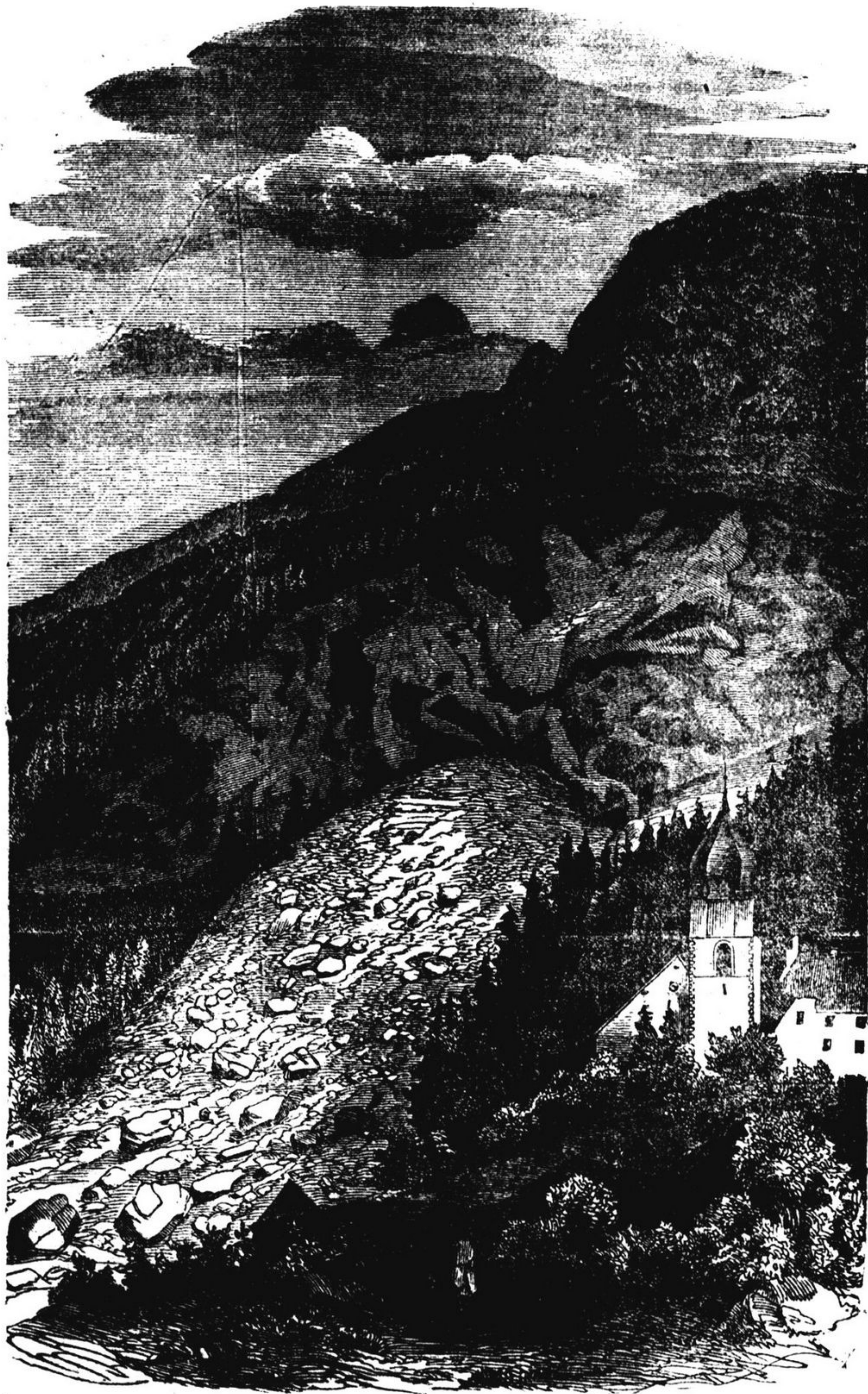
DERROCAMENTO D'UMA MONTANHA, PROXIMO DE PFAEPPERS, NA SUISSA.
