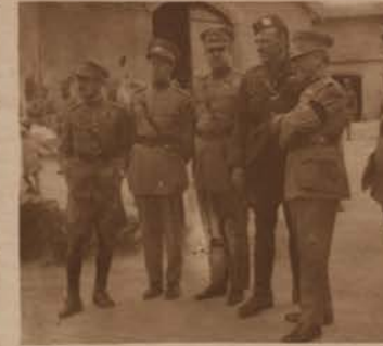
VISITA DO AGIDO MILITAR INGLEZ AO QUARTEL DE SAPADORES DE CAMINHOS DE FERRO.—(Clicé Serra Ribeiro).
