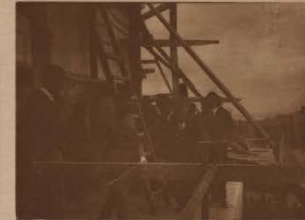
VISITA DE S. E. O SENHOR PRESIDENTE DA REPUBLICA ÀS OBRAS DO MONUMENTO AO MARQUEZ DO POMBAL.—(Clicé Serra Ribeiro).
