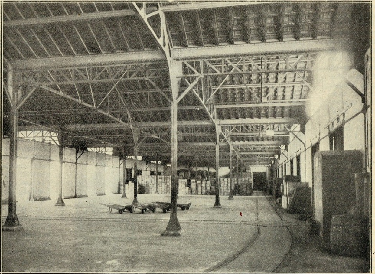
O interior de um dos armazens do Porto de Lisboa
