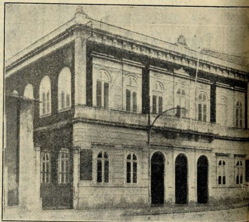
Filial da Caixa Geral de Depósitos, de Braga
