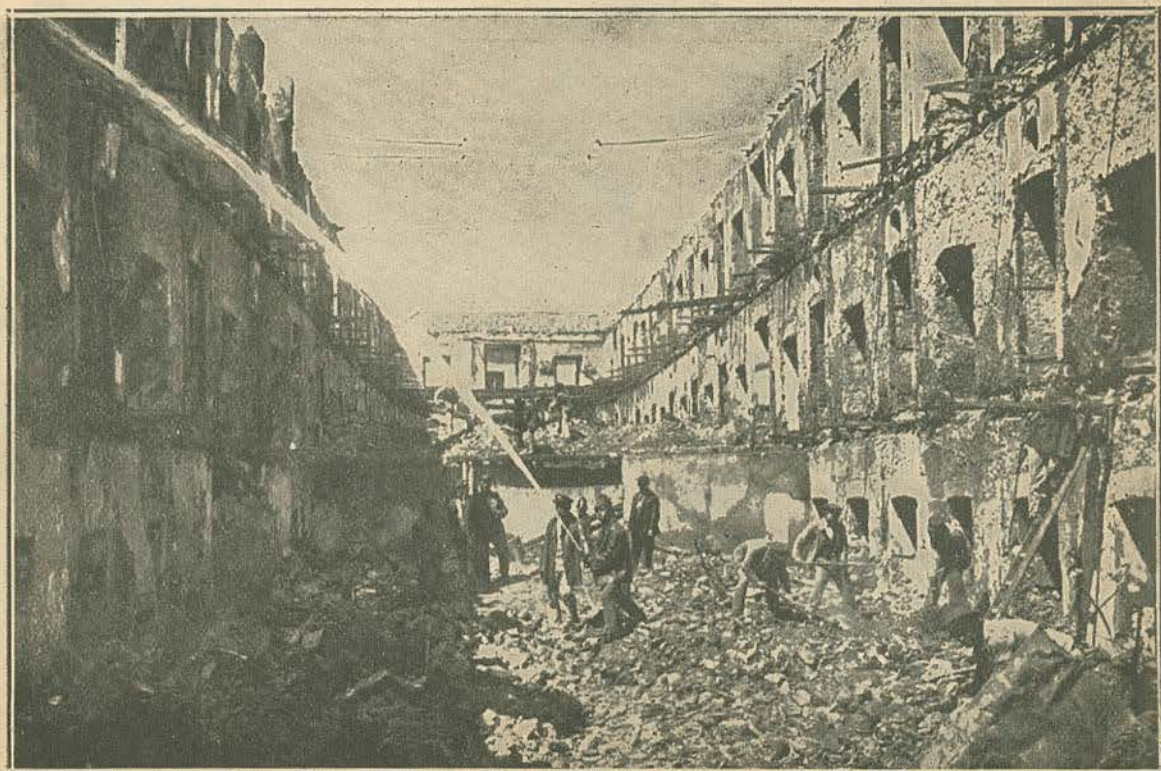
O interior da parte incendiada do velho mosteiro, por ocasião do rescaldo, isto é, na madrugada do pavoroso sinistro que tanto alarme causou em Lisboa
