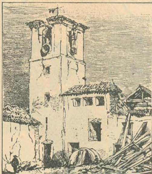
Egreja em ruínas em Albuñuelas
