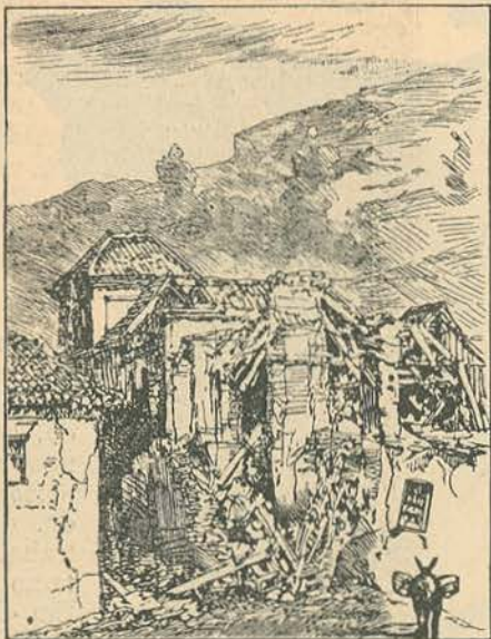
Casas em ruínas em Albuñuelas
