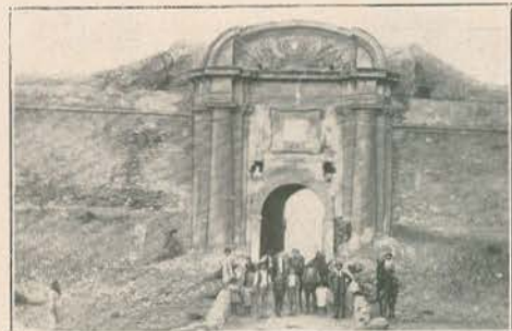
Antiga porta de Santa Maria, que tem escapado ao camarello demolidor do progresso
