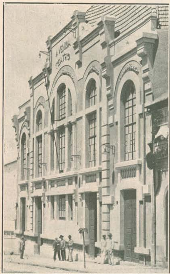
Fachada do «Avenida Teatro»
