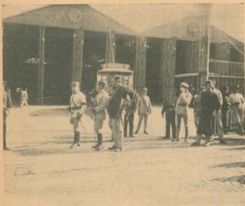
Em Santo Amaro. A estação guardada
