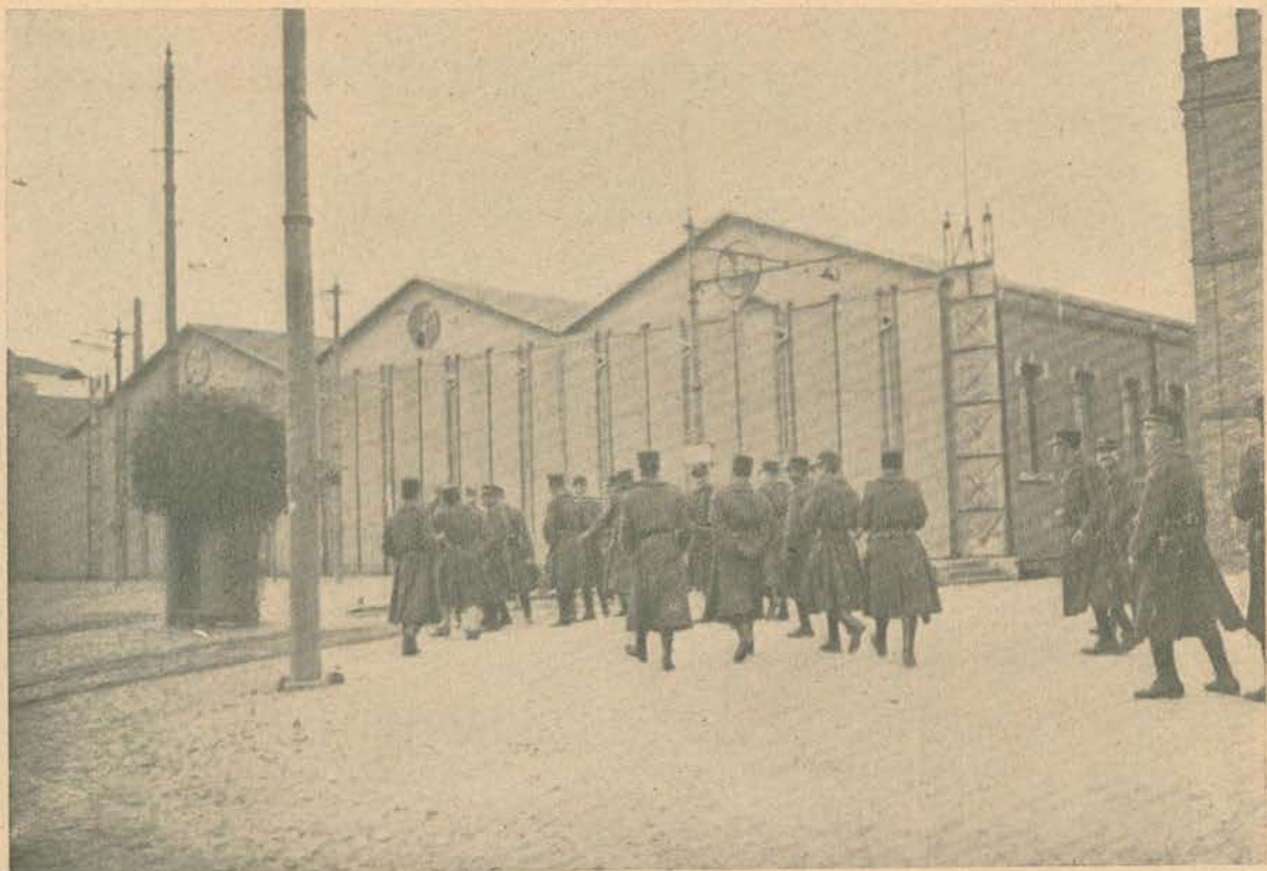
Em Santo Amaro. A estação guardada
