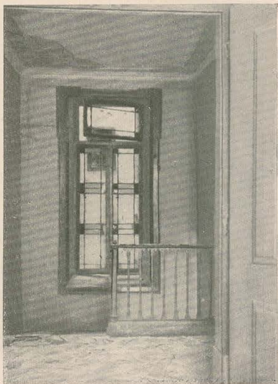
No patamar do cima da escada. O tecto esburacado.
