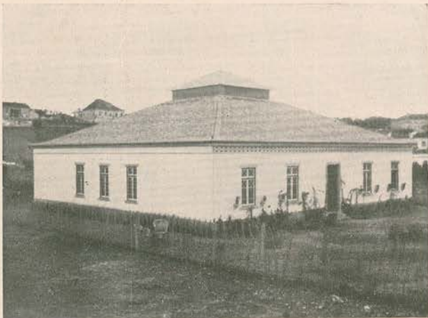
A casa da sr.ª D. Branca de Gonta, na Avenida da Luz
