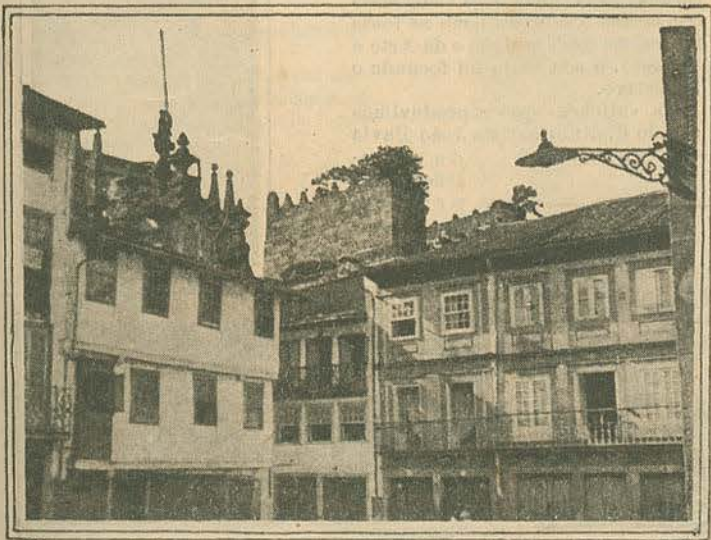
A torre que defendia a Porta Nova, vista pela parte interior das muralhas
