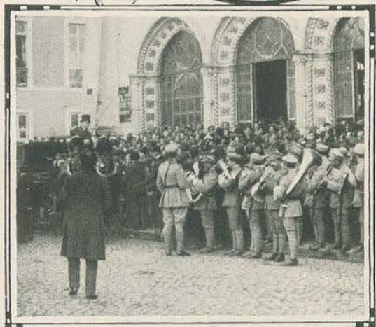
Chegada à estação de Lisboa.
