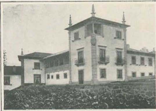
Vista da casa, lado Norte
