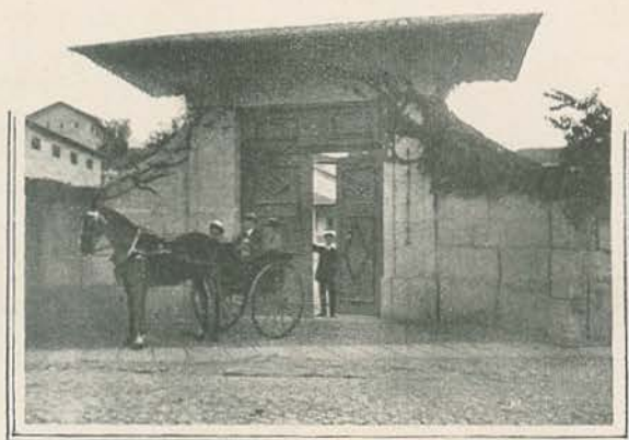
O telheiro do portão da entrada
