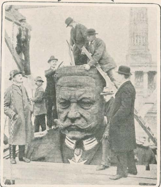
O principio do fim. Começa a demolir-se a estatua de Hindenburgo. (No medalhão o marechal Hindenburgo).
