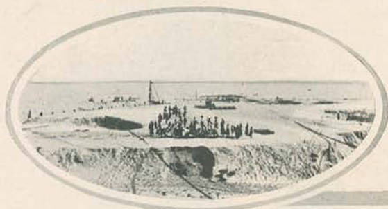
Início dos trabalhos. O canal a dragar.
