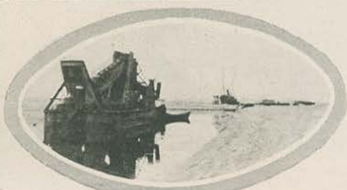
A draga «Aveiro» em reparações no canal.
