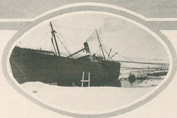
Barco de pesca transformado em draga que recebe vapor das caldeiras do navio por tubos flexíveis, mostrando-se a parte do lago que, em volta do navio foi aberta por ele.
