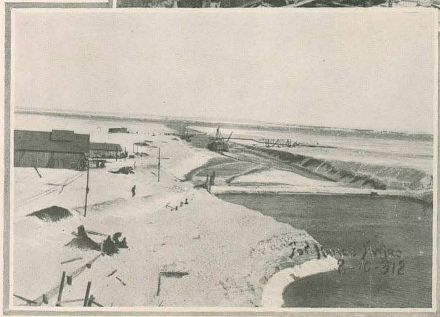
O canal que da ria de Aveiro á costa abriu a engenharia portugueza para pôr o «Desertas» novamente a fluctuar.
