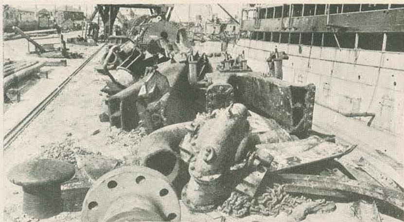
Peça de maquinismo do «India» partidas e tornadas inaproveitadas pela explosão do torpedo.
