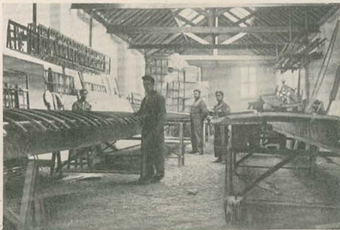
Aspêto da oficina de construção, vendo-se á esquerda o esqueleto de um aparelho.
