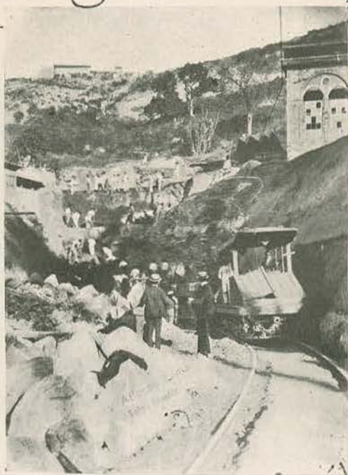
Um aspéto dos trabalhos para se fazer uma abertura no tunel João Ricardo, do lado da rua do Livramento.
