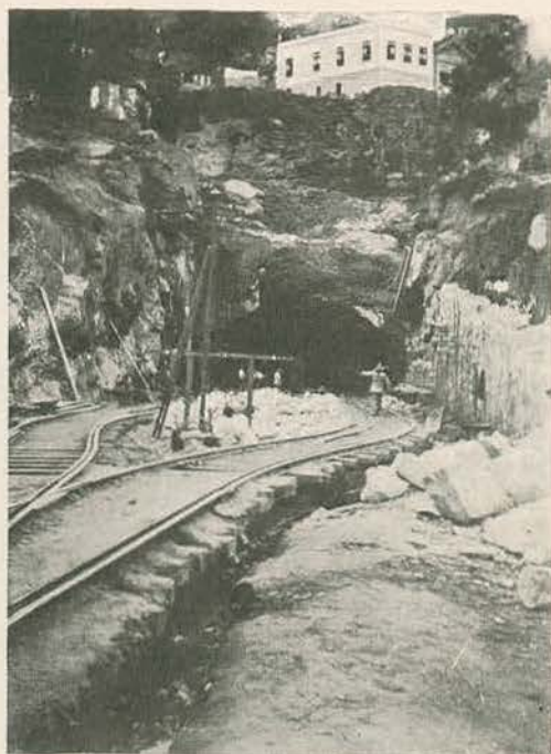
A abertura do tunel João Ricardo, ainda em construção, junto á estação Central dos Caminhos de Ferro, e que, passando sob o morro do Livramento, dará acesso ao caes.
