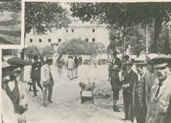
Vendo o rego aberto na placa do Rocio, para n'ele ficar situada a orla da rua que atravessará a praça. («Clichés» Serra Ribeiro).
