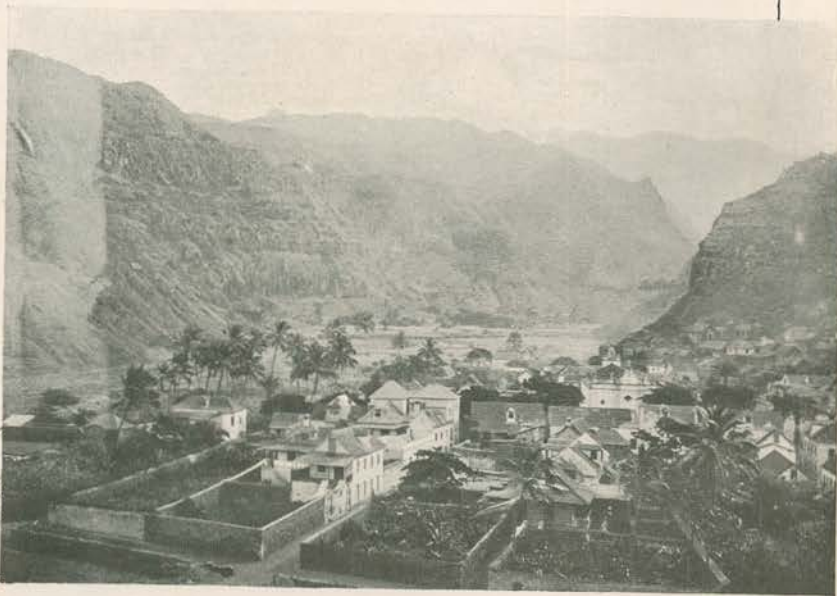
Vista geral da Vila da Ribeira Grande, antiga séde do concelho do mesmo nome e o centro comercial de maior dependencias do quartel da policia e da guarnição (4.ª zona), das escolas centraes do concelho, da estação telegraphica dos Carvoeiros com a da Ponta do Sol e do Paul.—«Clichés do distinto amador sr.
