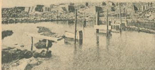
Um aspéto da primeira linha passando atravez de terrenos inundados.
