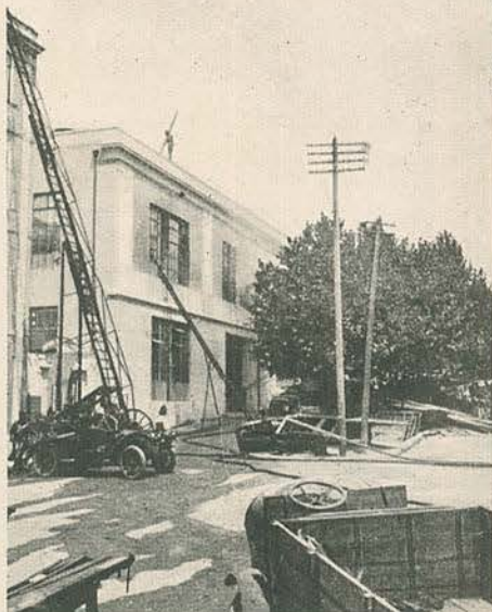
A fachada do edificio da garage do P. A. M. sobre a rua do Viriato, na ocasião em que os bombeiros municipais se esforçavam por debelar o violento incendio que ali se manifestára.
