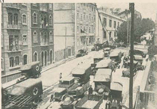
Na Rua do Viriato — Os automoveis que foram retirados da garage do P. A. M. ao declarar-se o incendio, vendo-se ao fundo, á esquerda da fotografia, o edificio d'aquella.
