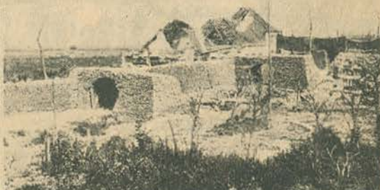
Outra trincheira da primeira linha, em que foram incluídas as ruínas d'uma herdade.
