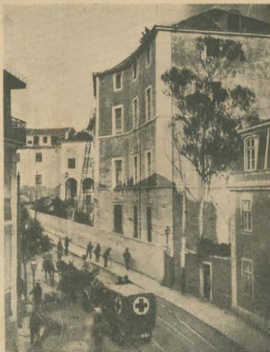
Um aspecto dos primeiros trabalhos de ataque ao incendio, que destruiu algumas dependencias da cadeia civil central, no momento em que o fogo começava irrompendo com maior intensidade. No telhado do edificio vêem-se alguns reclusos implorando socorro.
