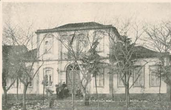
A fachada do edificio
