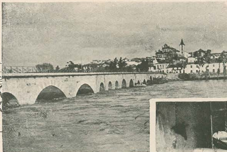
A ponte de Mirandela sobre o Tua, o maior obstáculo para as forças que diligenciaram entrar na pitoresca vila transmontana.
