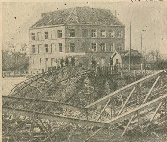
Em Ath.—As ruínas, da fabrica do importante industrial M. Fontaine.
