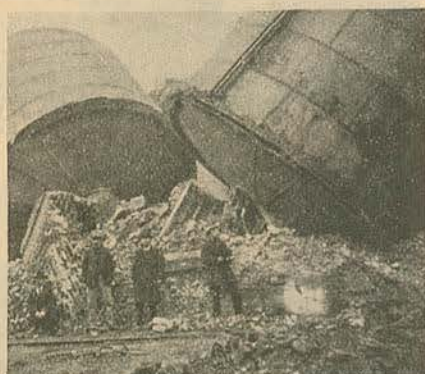
Destroços da fabrica geradora de electricidade
