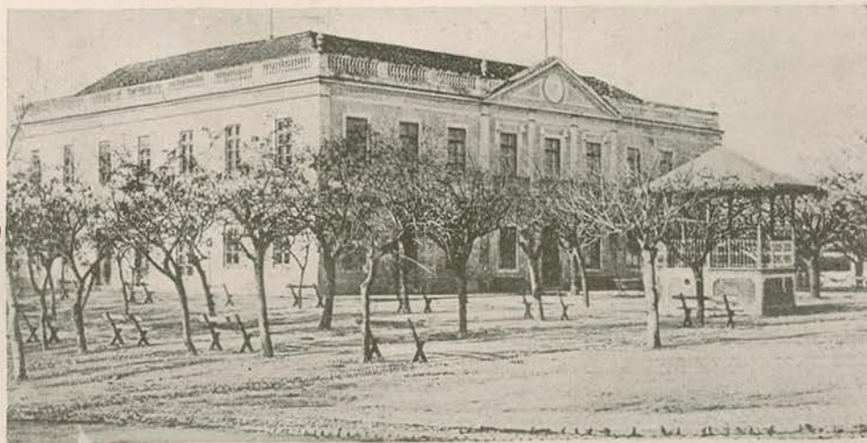
Cartaxo. - O edificio dos Paços do concelho, onde esteve instalado o quartel general das forças fieis ao governo
